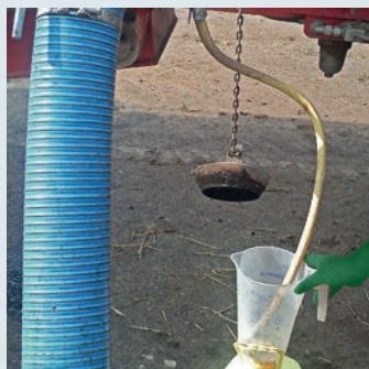
Zudosierung über Bypass
